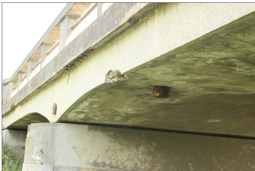
11- v poli 2 - odprýsknutá hrana betonu - koroze výztuže.JPG
