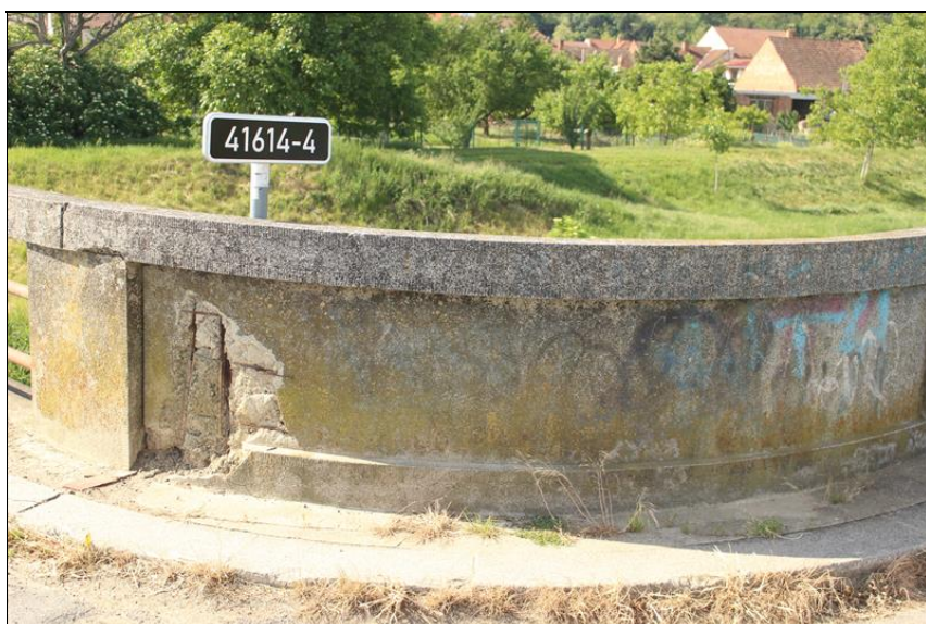
15-pohled na zábradlí vpravo - oprýskaný beton - obnažená korodující výztuž.JPG
