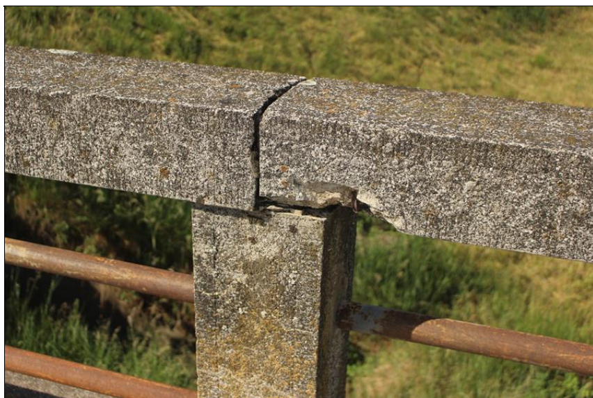
17-degradace madla v napojení na sloupek.JPG
