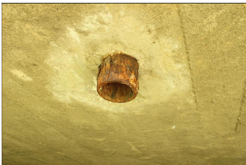
12-koroze odvodňovače - vápenné výluhy kolem.JPG
