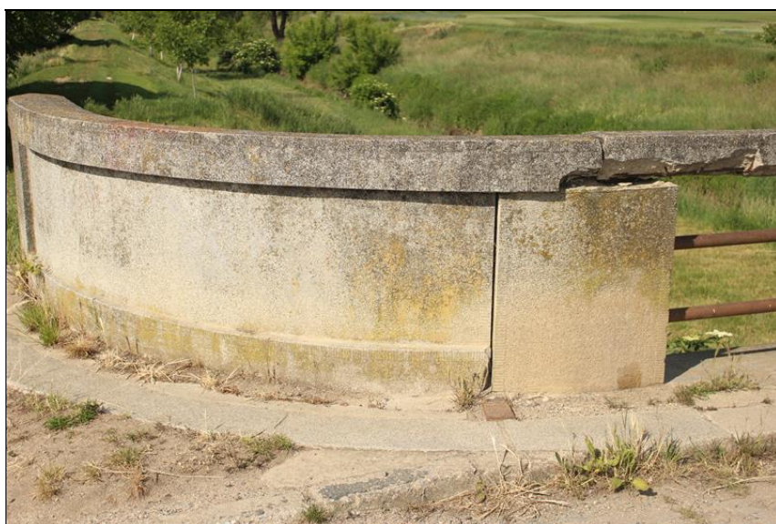
18-degradace madla v délce 80 cm v napojení na sloupek.JPG
