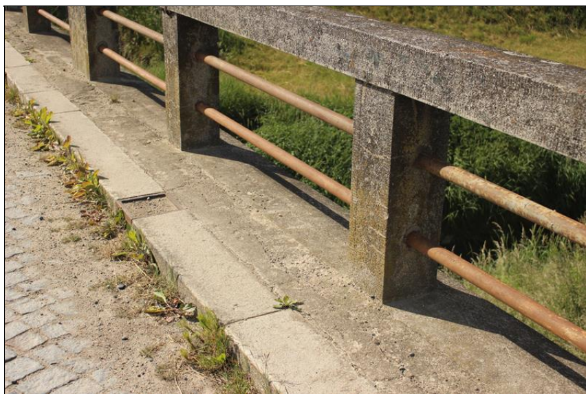
16-Nánosy a vegetace u říms - korodující výplň zábradlí.JPG
