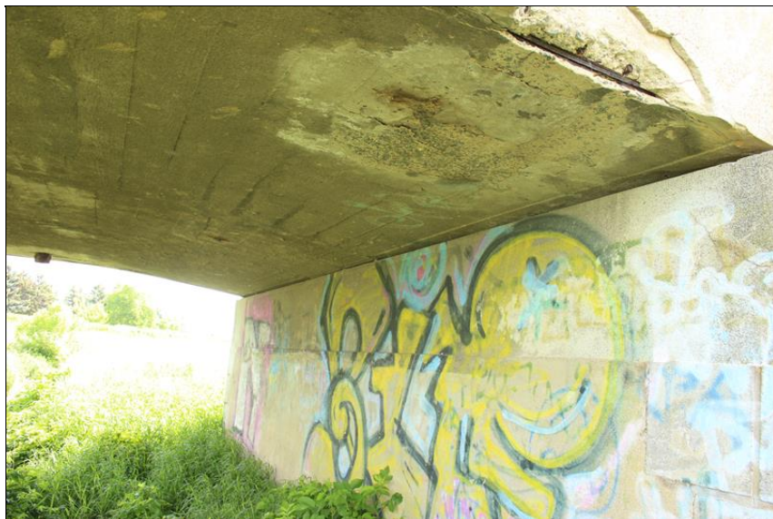
10-v poli 3 - obnažená hrana NK - korodující výztuž.JPG
