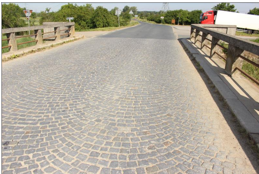
20-vozovka na mostě - projeté koleje.JPG
