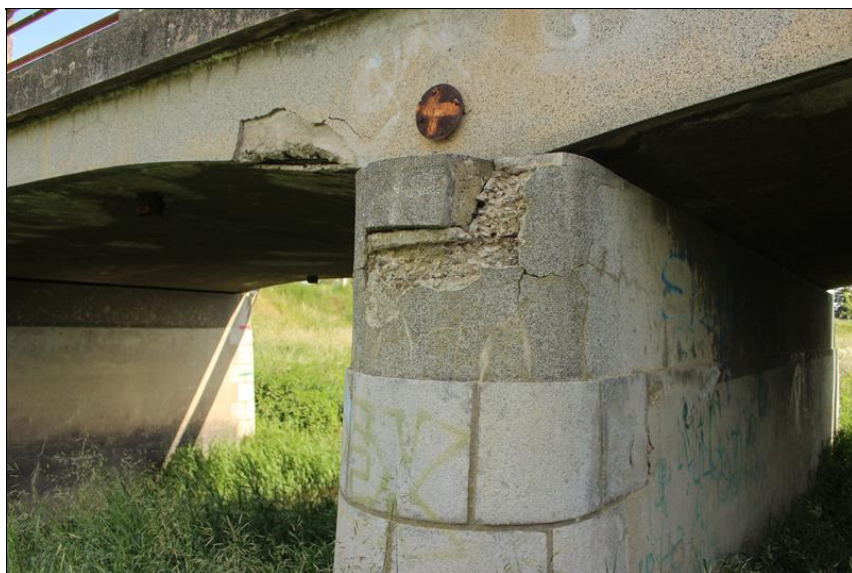
14-narušený úložný práh u pilíře 3 vpravo.JPG
