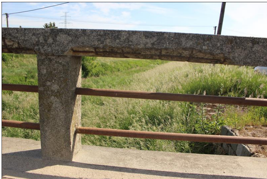
19-degradace spodní hrany madla - obnažená výztuž.JPG
